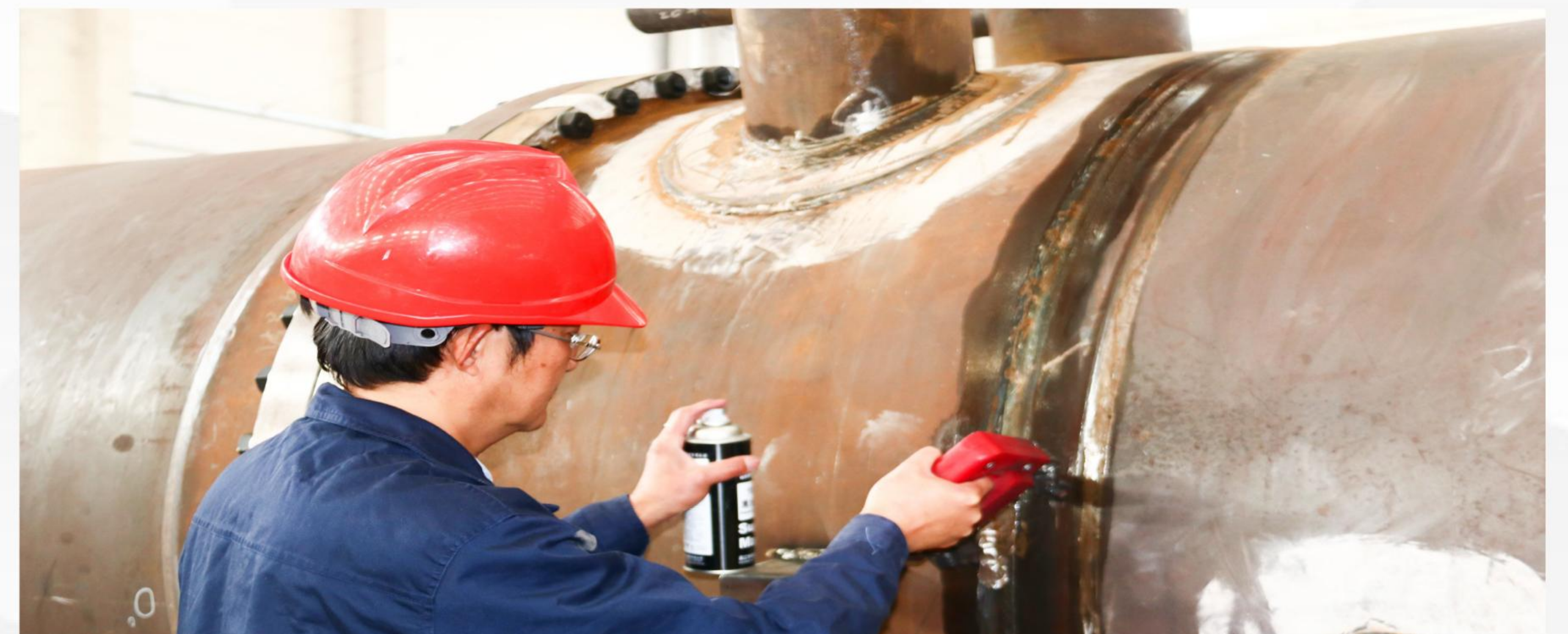
فحص الجسيمات المغناطيسية Magnetic particle testing
