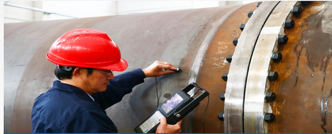
超声波探伤 Ultrasonic testing
